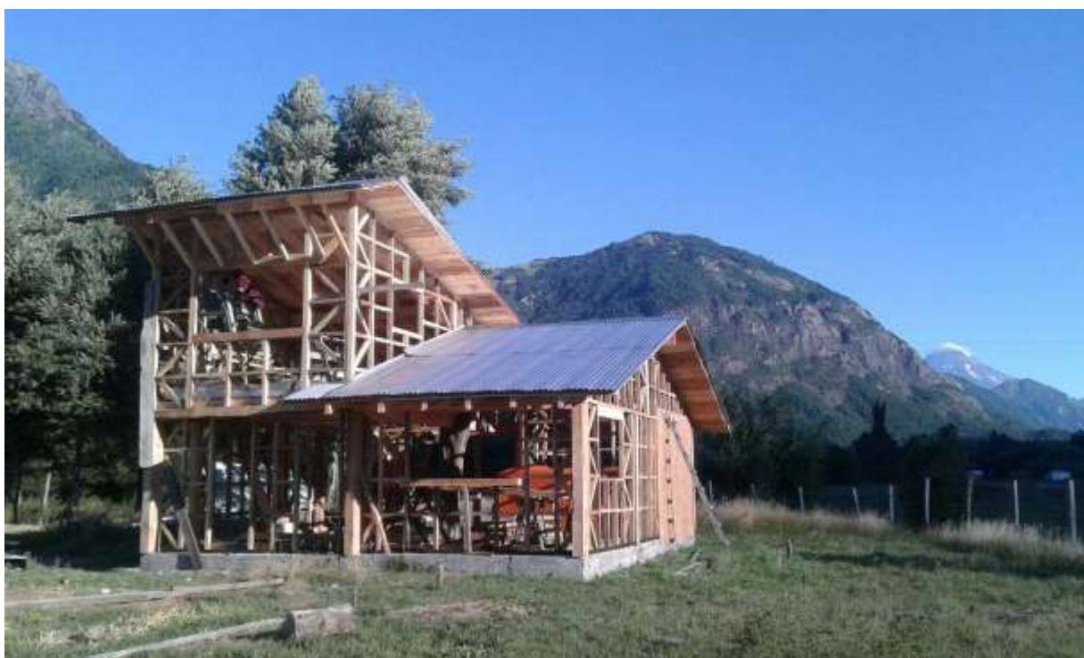
Maison de François en construction
