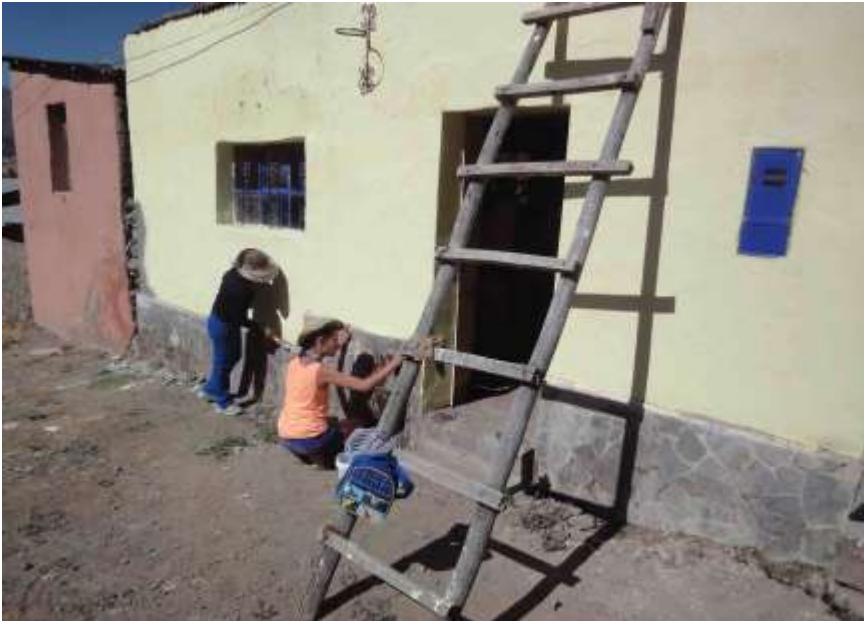
Rénovation de la salle à manger communautaire
